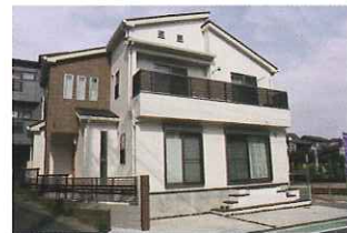
②モデルハウス外観写真 近隣にあるモデルハウスで、当社の施工した建物をご覧いただけます。
