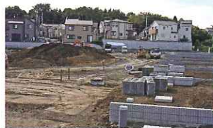
①バースシティ海老名4期・5期の現地写真 幅員 6.0m の開発道路と整形された区画や公園緑地など、住み良い環境が整っています。
